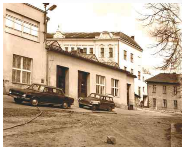
Budova prvního operačního sálu - po roce 1960 zde byla lyofilizace
